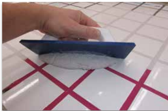
Zašlé a plesnivé spáry lze snadno přespárovat.
