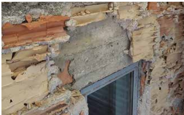
Obr. 4: Odstraňování klinkerových cihel a nekvalitního podkladu až na nosné zdivo
