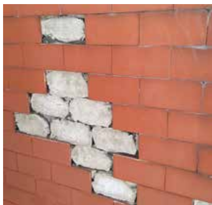
Obr. 1: Původní stav objektu
