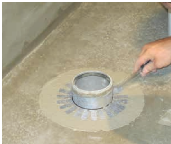
Obrázek 3: Do ještě živé hydroizolační hmoty vtiskneme elastickou těsnící pásku, kterou nastříháme do poloviny, označené černou čarou.
