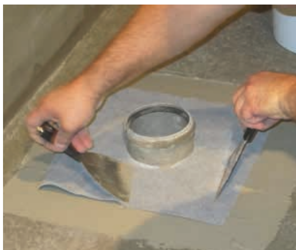
Obrázek 4: Kolem prostupu nanese se špachtlí dodatečnou vrstvu HIDROZOLU Elastik, do něj vtiskneme manžetu, do které vystříháme otvor velikosti průměru trubky.
