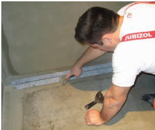
Obrázek 5: Hydroizolační hmotu nanese ještě na styk podlahy a stěny a vtiskneme do ní průběžnou elastickou pásku.
