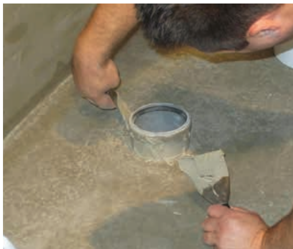
Obrázek 2: HIDROZOL Elastik nanášíme na suchou první vrstvu a po obvodu potrubí.
